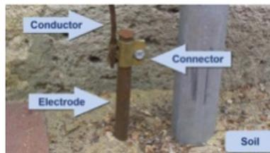
接地系统通常由接地线芯、搭接接头、接地电极（通常是接地棒或接地网系统）以及与电极接触的土壤组成。电极可被视为由（厚度相同的）泥土或土壤组成的同心环所包围——随着外环的横截面值越来越大，电阻值越来越小，直至接近零电阻。
