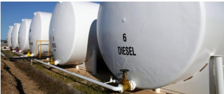
借助相连的油罐，储存规划人员可以按需使用多或少的储存容量，从而“正确规划”油罐容量需求。相连的成组油罐甚至可通过专用设备和泵来在储备设施间推送燃料。
